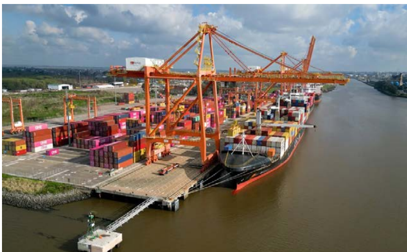
Vista de TecPlata, una de las terminales de contenedores más modernas de la Argentina.
