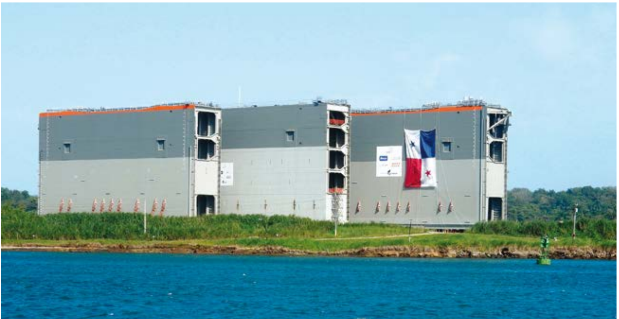
Las compuertas, listas para ser instaladas en el nuevo juego de esclusas.
