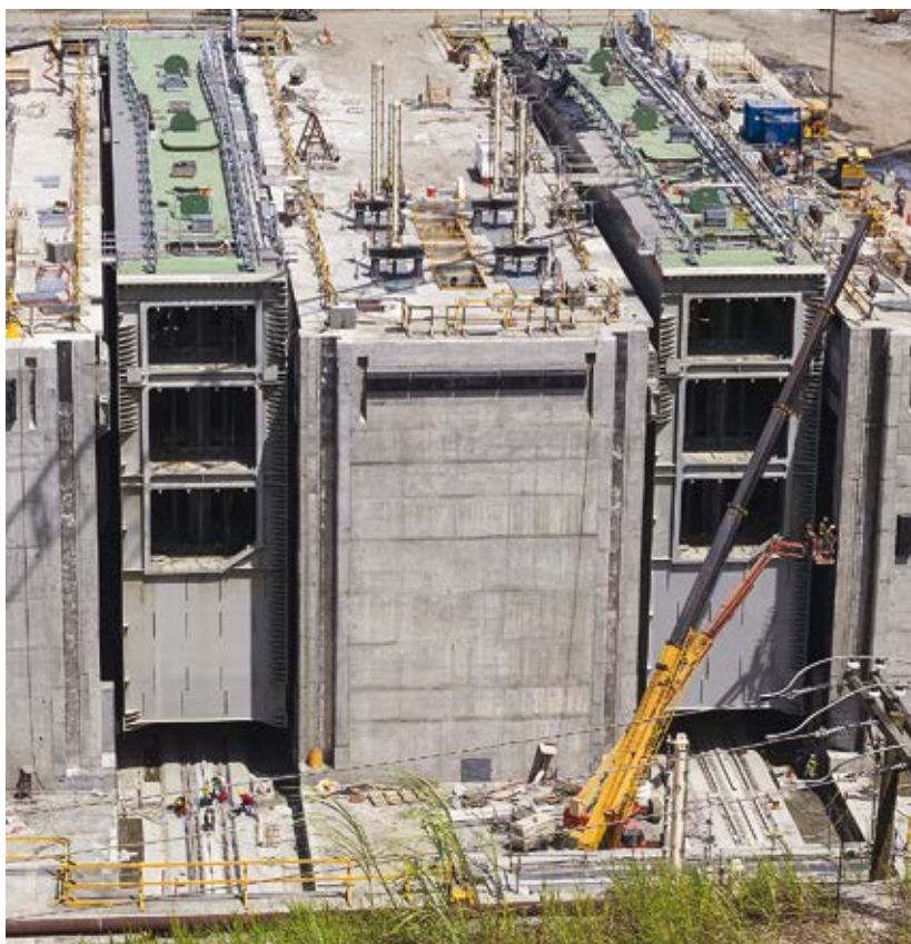
La expansión del canal se inaugurará este año.
