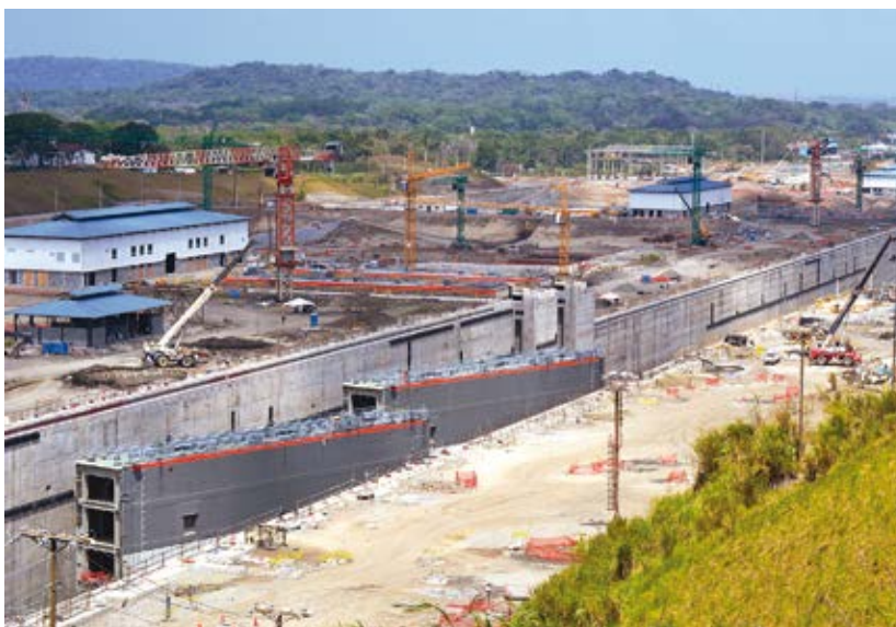
El sitio de construcción en pleno proceso.
