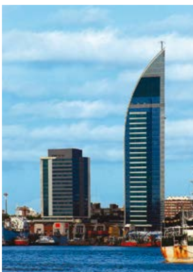
Complejo Torre de las Telecomunicaciones.
